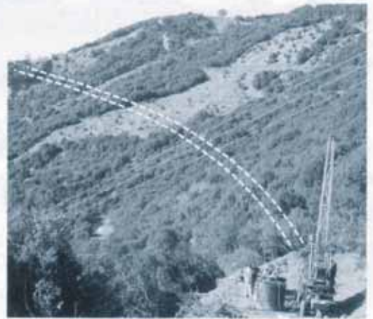
Die Trasse durch den Berg
