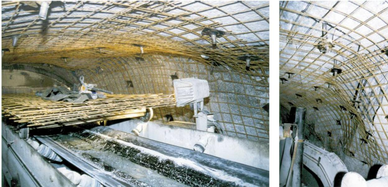
Bild 2: Niederbruch aufgrund Spannungsumlagerungen durch die Gripperverspannung beim Vortrieb des Druckstollen Amsteg (jeweils Blick in Richtung Bohrkopf der Gripper-TBM: links: Ausbruchstelle mit Felssicherung im Vortriebsbereich der Maschine / rechts: Detail der Ausbruchstelle,  $t_{\max} \approx 0,7 \text{ m}$ ) [9]
